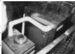
◀ 生ゴミ処理機の動力源となるガス温水ボイラー（写真左下）
