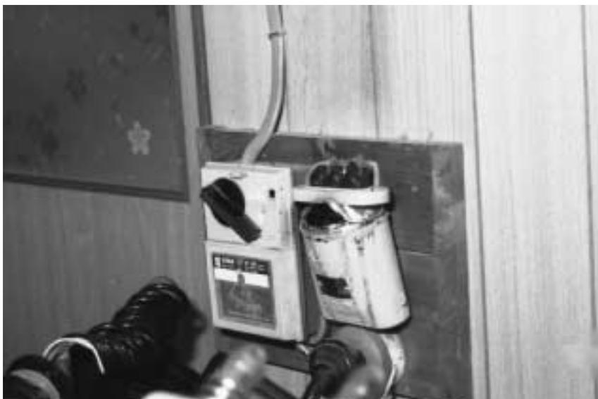
配電盤に設置されている低圧進相コンデンサ
