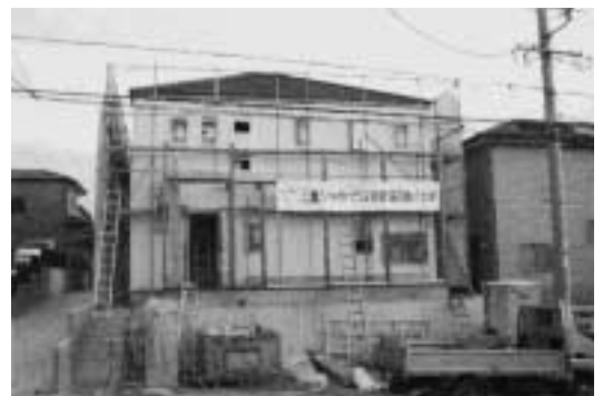
▲シックハウス対策施工例
